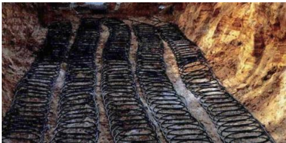
Рисунок 4 – Горизонтальный грунтовый коллектор
