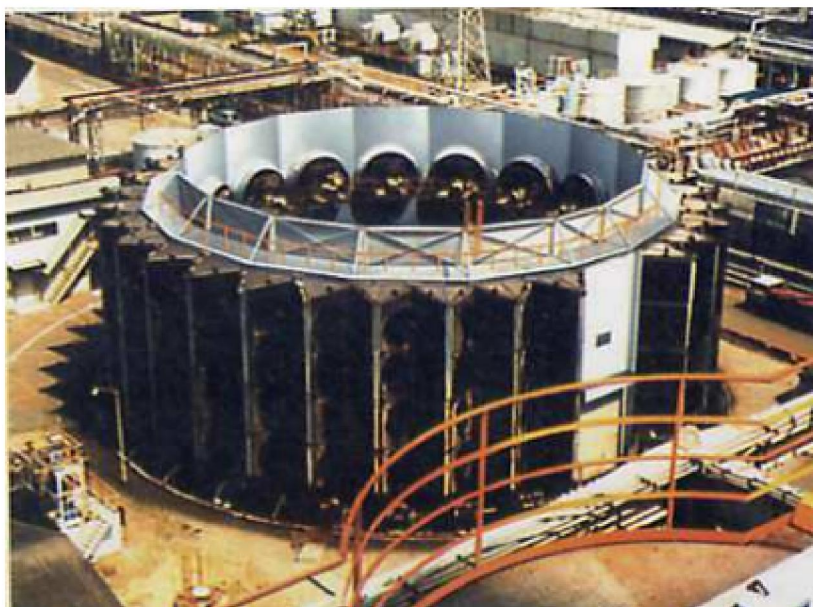
Рисунок 9- Геллеровская система с тягой принудительного характера и с водяным орошающим устройством [14]
