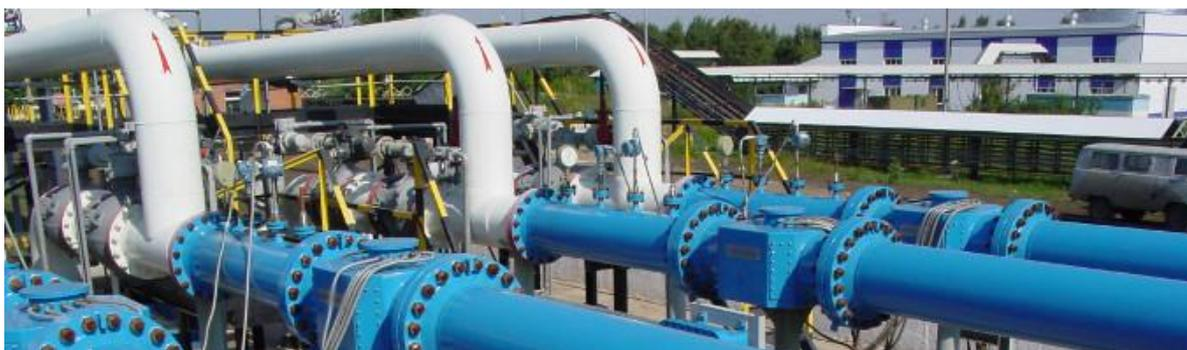
Рисунок 3.2 - Блок измерительных линий (БИЛ) [33]
