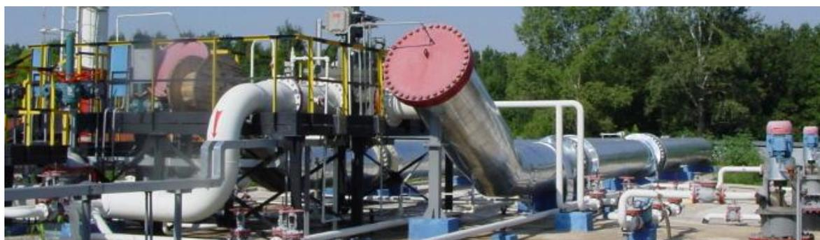
Рисунок 3.4 – Трубопоршневая поверочная установка [33]
