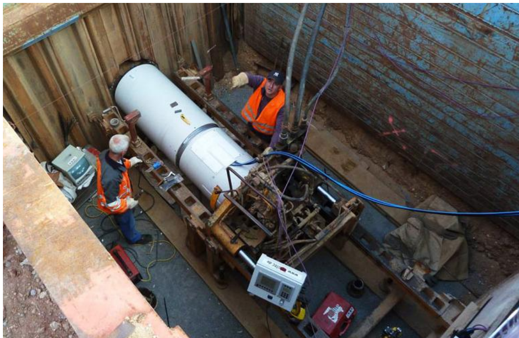
Рис. 2.3. Процесс микротоннелирования
