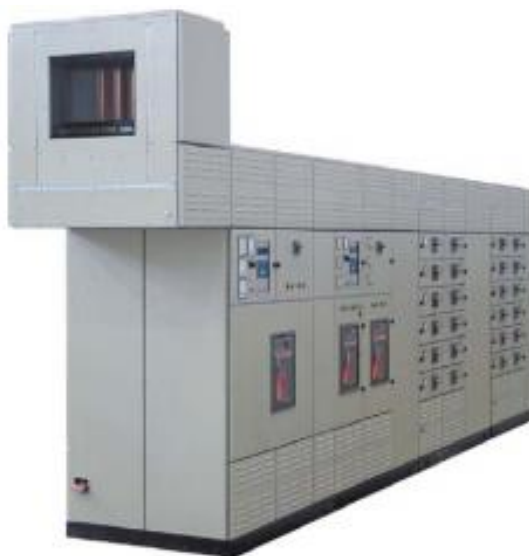
Рисунок 2.4 – распределительное устройство РУ-0,4 кВ на базе НКУ ЩО-2000 «Нева»
