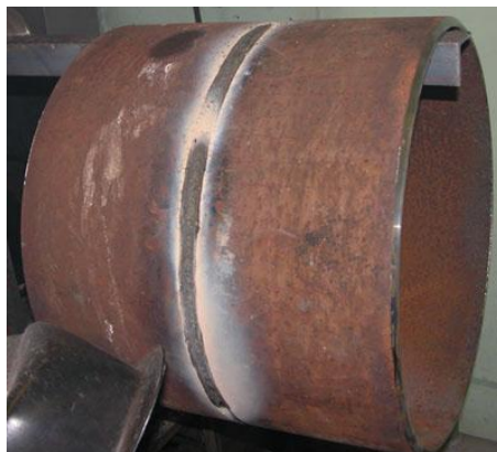
Рисунок 4 – Сварка катушки на консольном уголке
