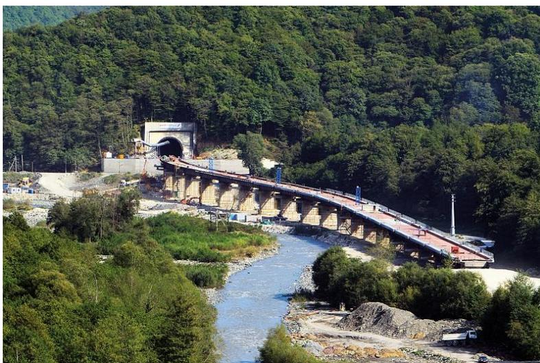
*Рис. 4.1. Железнодорожная эстакада к тоннельному комплексу №6 на трассе Адлер – Красная Поляна*
