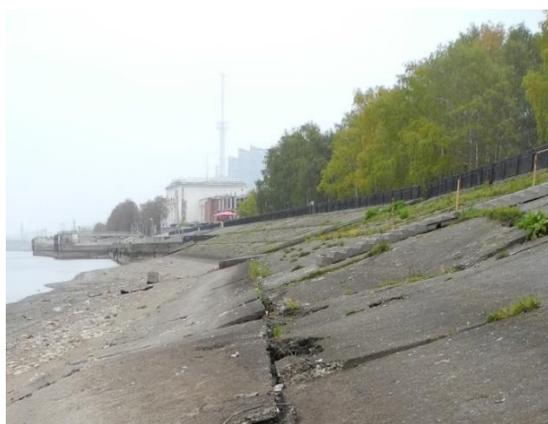
*Рис. 2.14. Проседание и деформация плит в результате суффозионных процессов [1]*
