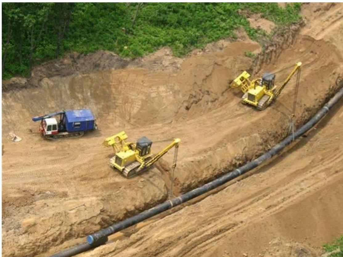
Рисунок 2.1.2.2 Укладка трубопровода в траншею трубоукладчиками
