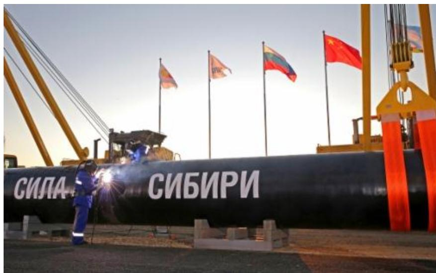
Рисунок 2.1 – Сварка первого стыка газотранспортной системы «Сила Сибири»,
