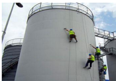
Рисунок 4 – Нанесение антикоррозионного покрытия с наружи
