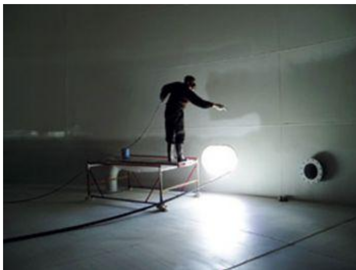
Рисунок 5 – Нанесение антикоррозионного покрытия внутри
