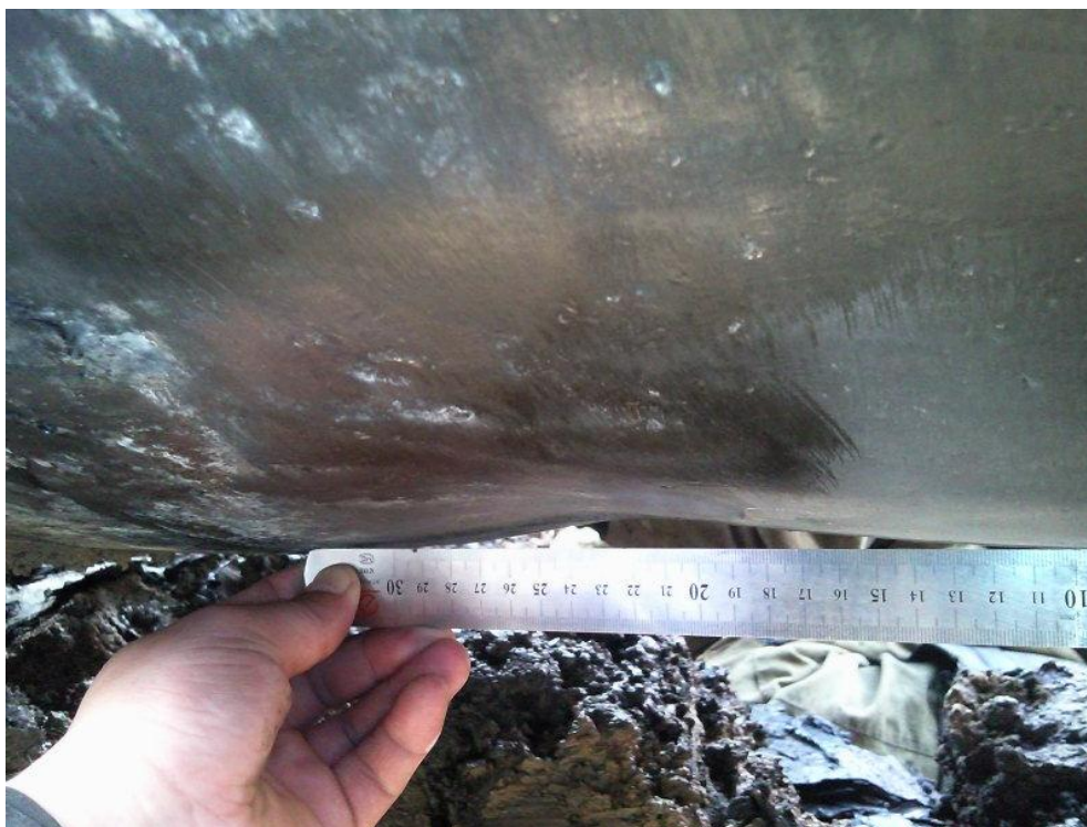
Рисунок 1 – Дефект в виде гофры
