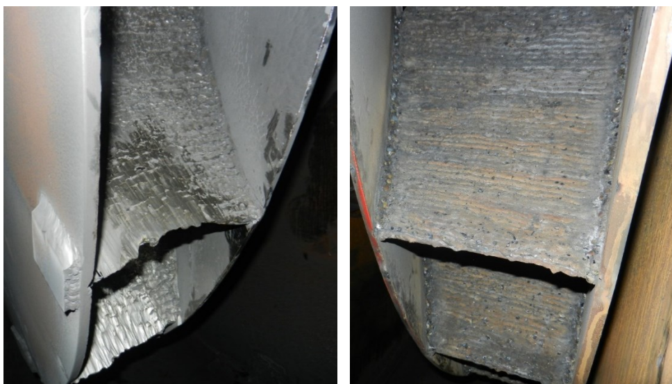
Рисунок 11 – Слева – Изношенная поверхность лопасти рабочего колеса мельничного вентилятора. Справа – Ручная дуговая наплавка покрытыми электродами т-590 на лопасти рабочего колеса.
