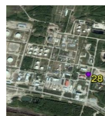
Территория центрального товарного парка (ЦТП)
