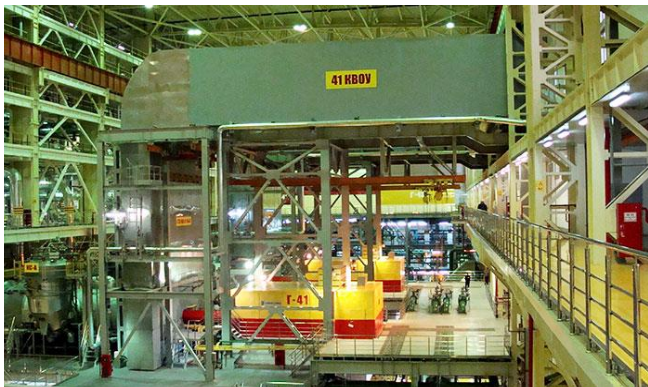
Рисунок 3- Комплексная воздухоочистительная установка (КВОУ) [5]
