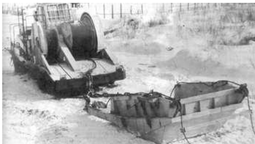
Рис. 4. Скреперное оборудование для двухбарабанных лебедок ЛС302
