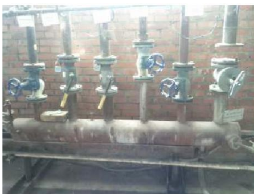
Рис. 5 – Неизолированные трубы пара на комбинате.
