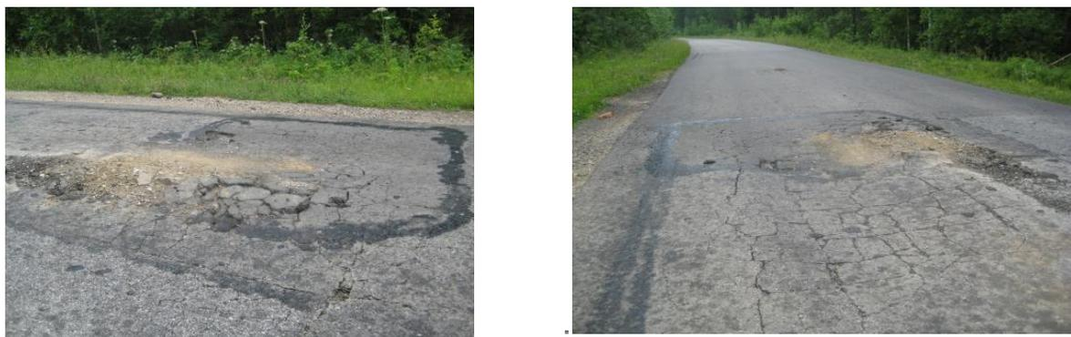
*Рис. 5.57. Нарушение дорожного покрытия (дорога на п. Орловка за 2 км перед мостом через р. Мостовку)*
