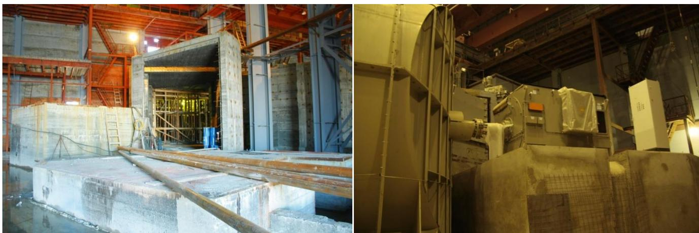
Рис. 7.6 Монолитный фундамент под вентиляторную установку Novden, изготовленный на разработанной быстротвердеющей бетонной смеси
