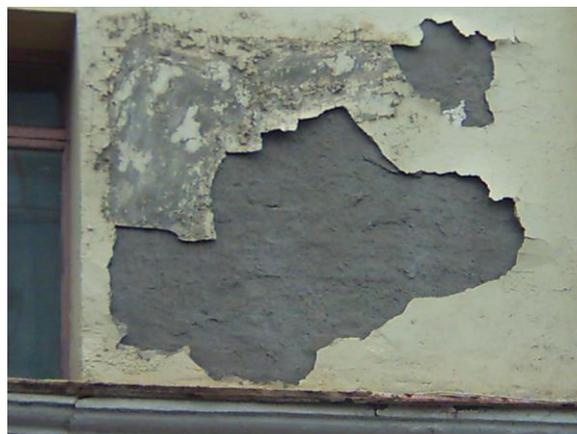
Рис. 5.2. Отслаивание фасадных покрытий при эксплуатации зданий в районе Талнах (1), микрорайон Оганере (2), г. Норильске (3), г. Новосибирске (4), районе Кайеркан (5).
