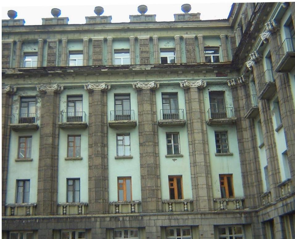
Рис. 7.3. Меление и выцветание фасадных покрытий в г. Норильске:
