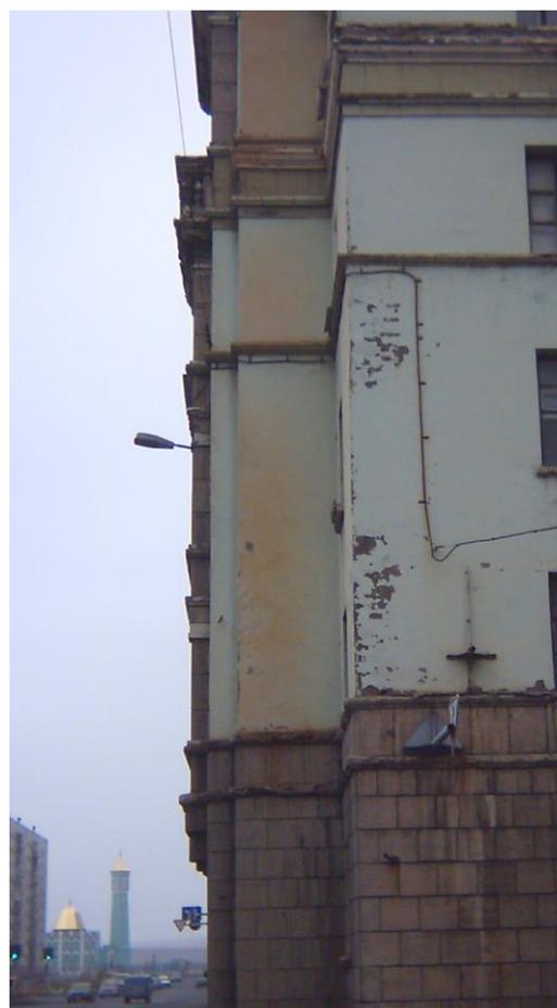
Рис. 7.1. Вспучивание и отслаивание фасадных покрытий
