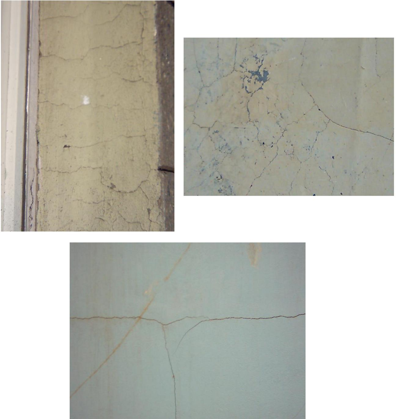
Рис. 7.2. Трещины на фасадных покрытиях зданий г. Норильска
