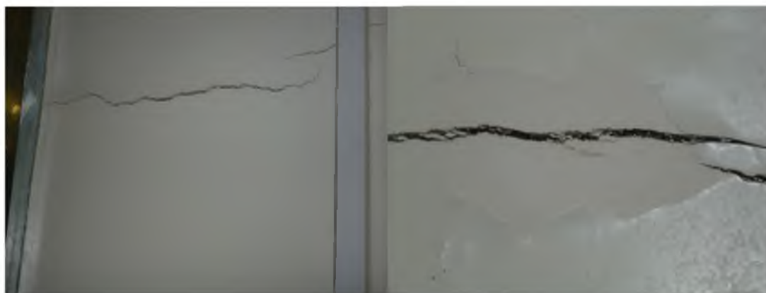
Рис. 7.2 Фотографии некачественных стекло-магнезиальных листов после длительной эксплуатации в условиях высокой влажности (~90%)
