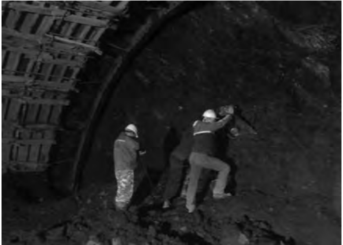
Рис. 5.13 – Пример проведения ЭМИ СШП измерений вперед забоя при проходке комбинированным способом
