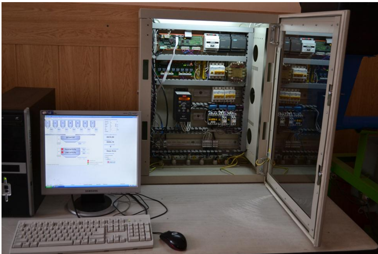
Рис. 4.4. Шкаф управления системой автоматического дозирования сыпучих материалов
