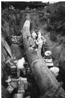
Рис. 1. Установка муфты КМТ
