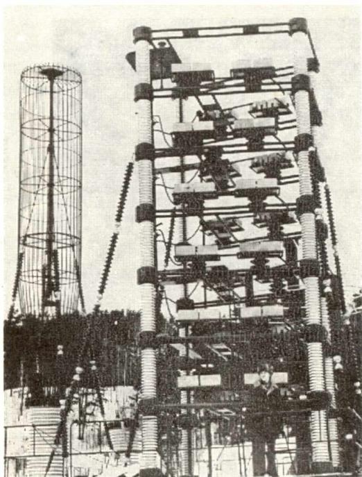
Источник электромагнитных импульсов напряжением до 3 млн. вольт, разработанный и изготовленный в НИИВН
