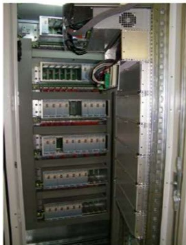
Рис. 1. Пульт управления системой EXFIRE 360
