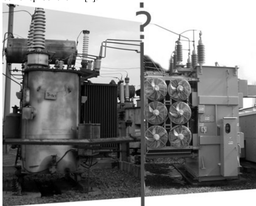
Рис. 1. Замена силового трансформатора
