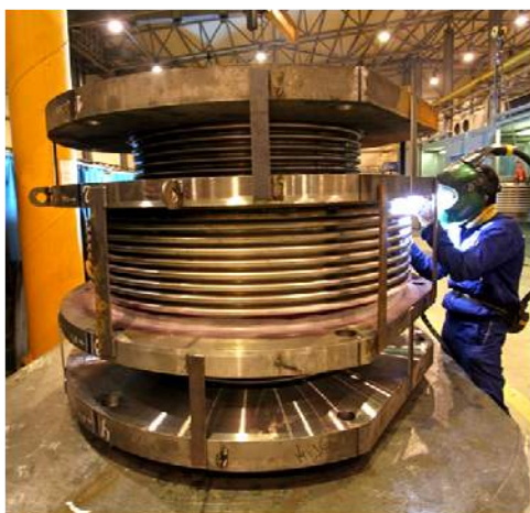
Рис. 1. Сильфонный компенсатор и его контроль
