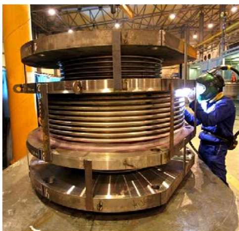
Рис. 1. Сильфонный компенсатор и его контроль
