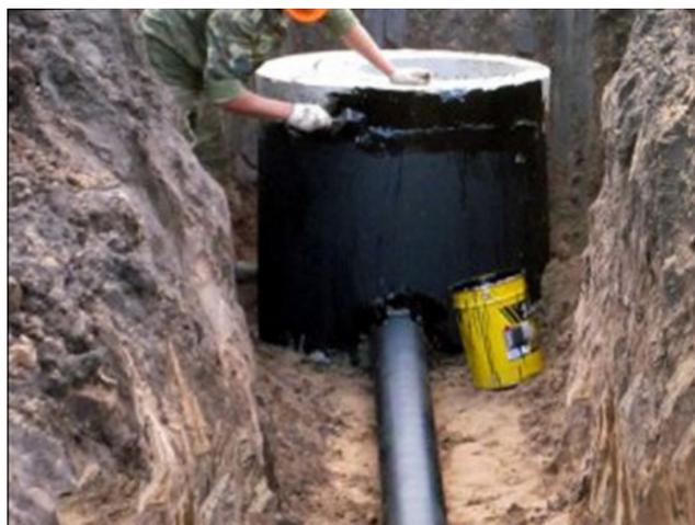
Рис. 3. Гидроизоляция битумом
