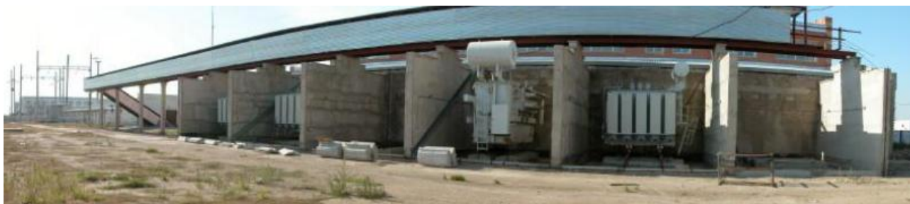
Рисунок 11 – Преобразовательные трансформаторы для питания обмоток
