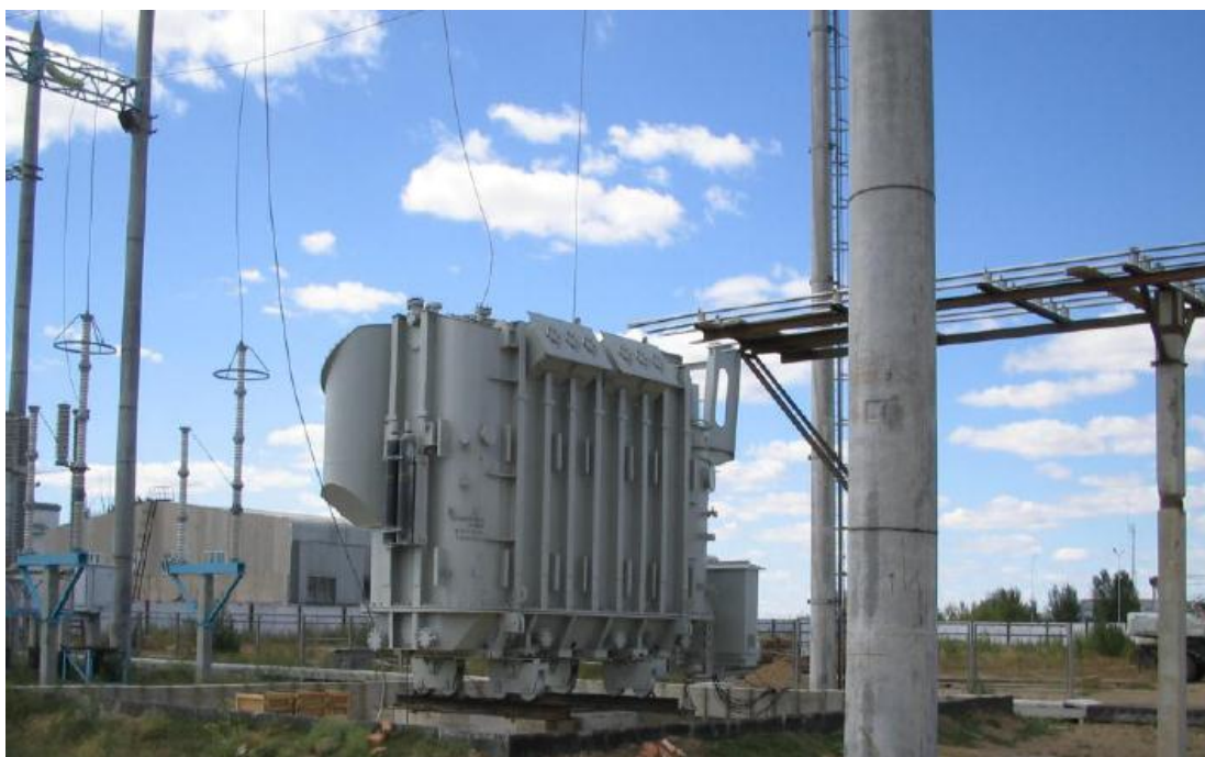
Рисунок 9 – Головной силовой трансформатор
