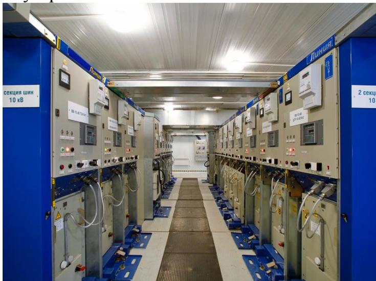
Рис. 1. Комплектное распределительное устройство
