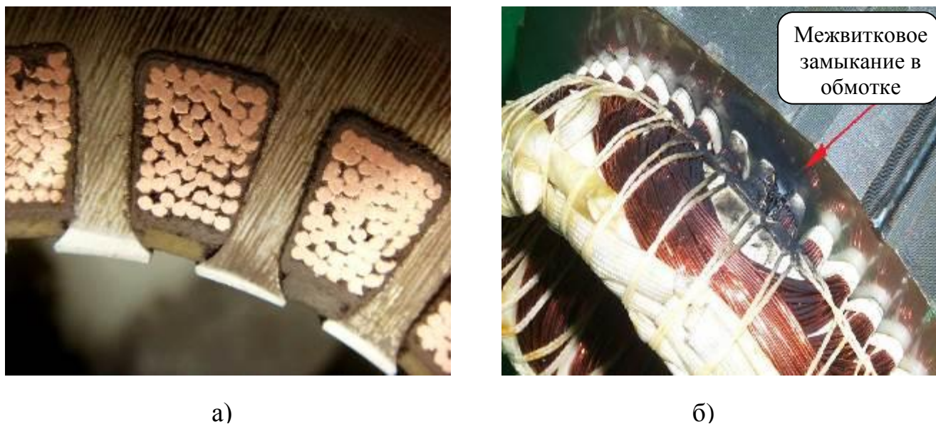
Рисунок 1.2 – Общий вид межвитковой изоляции обмотки (а) и характерный вид межвиткового замыкания (б).
