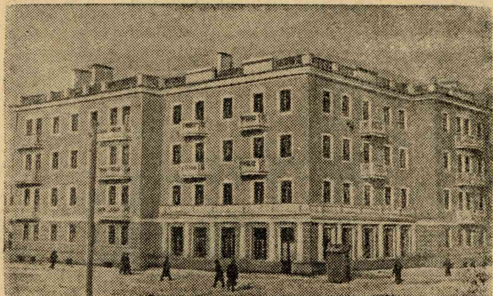
Новый 40-квартирный дом горняков шахты № 1-бис в Караганде. Дом построен скоростными методами за 60 дней.
