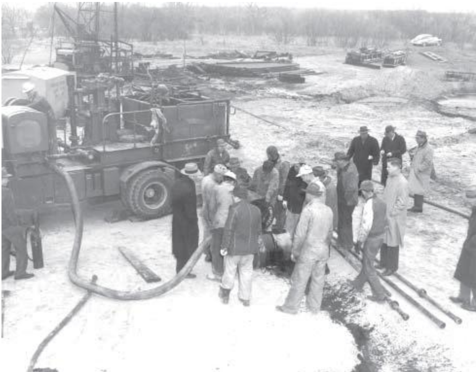
Abbildung 1 – Eine frühzeitige hydraulische Frakturbehandlung, circa. 1949.
