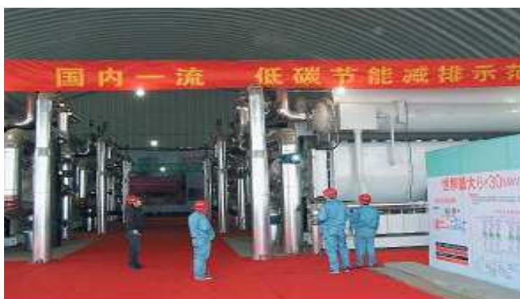
Рис. 1. Теплонасосное оборудование ТЭЦ г. Янжжин.
