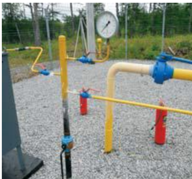
Рисунок 2.1 – Внешний вид стояка отбора импульсного газа [23]
