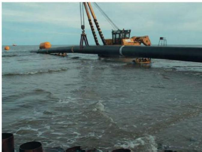
Рисунок 1 - Процесс протягивания нефтепровода [1]
