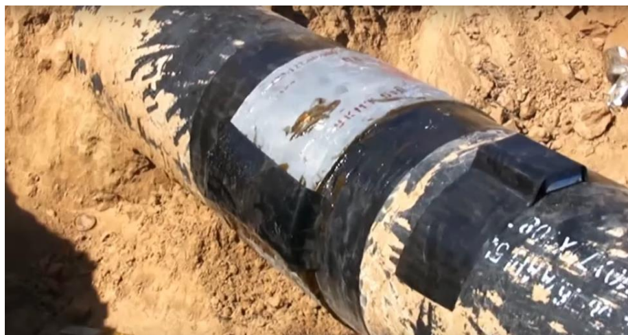
Рисунок 11 – Отремонтированный участок трубопровода[24]
