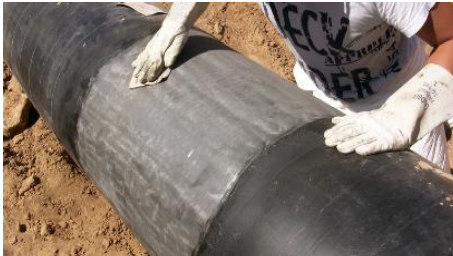
Рисунок 7 – Очистка и обезжиривание поверхности [24]
