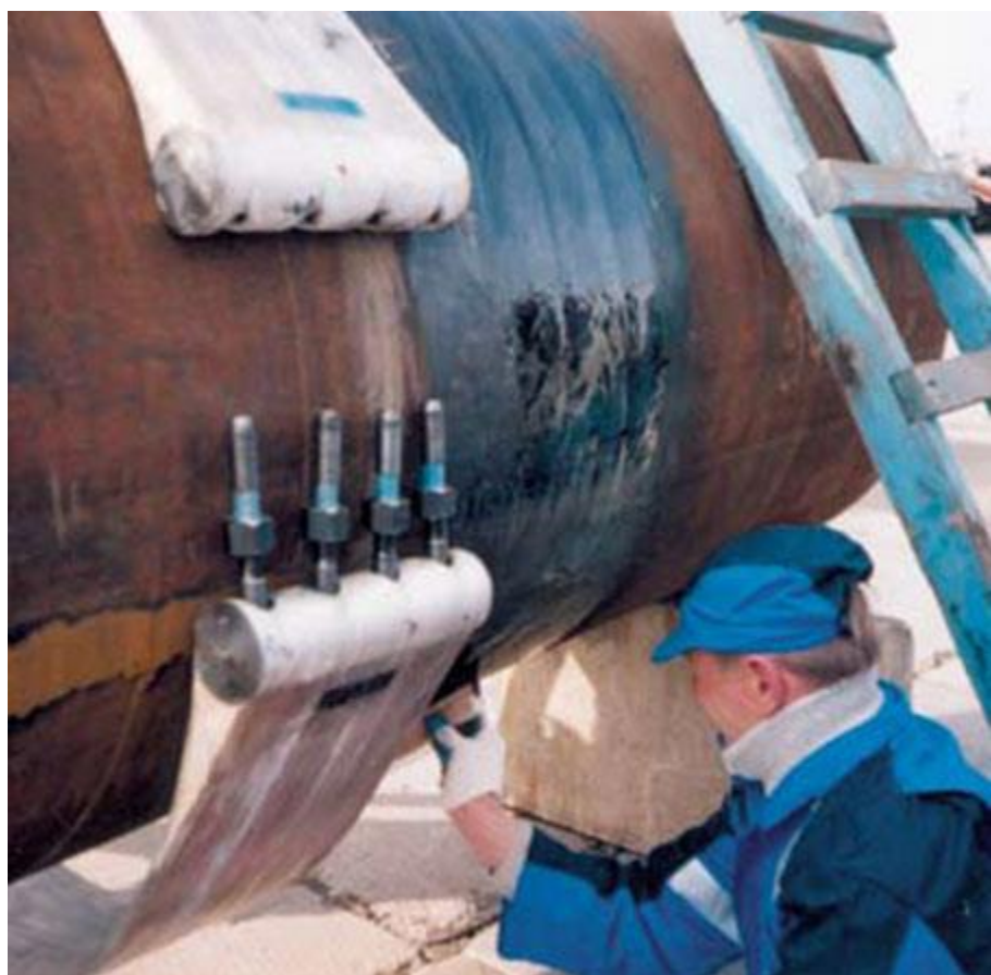
Рисунок 6 - Установка на трубу диаметром 1220 мм стеклопластиковой муфты РСМ-1220 [10]
