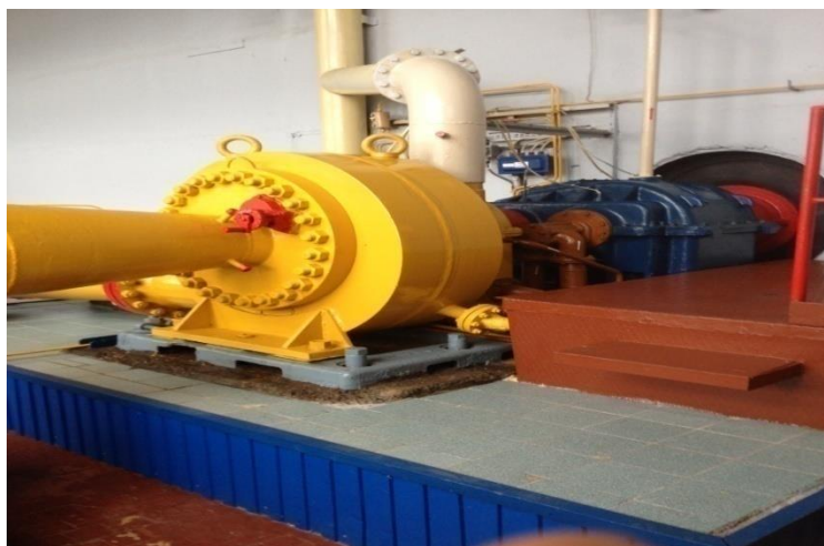
Рис 2.1 – Центробежный нагнетатель типа 280-12-7
