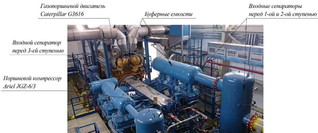
Рисунок 2.4 – Состав компрессорной установки
