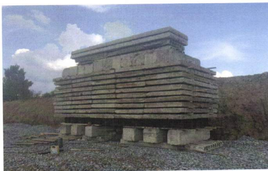
Рис. 3.14. Установка с грузовой платформой, служащей упором для гидравлического домкрата
