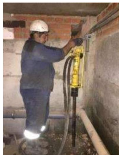
*Рисунок 3.9. Процесс нагнетания раствора под фундамент здания [136]*
