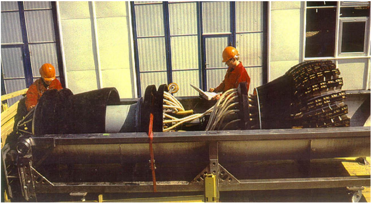
Рис. 10. Ультразвуковой дефектоскоп – «Ультраскан» (определение коррозии, расслоений, рисок, включений)
