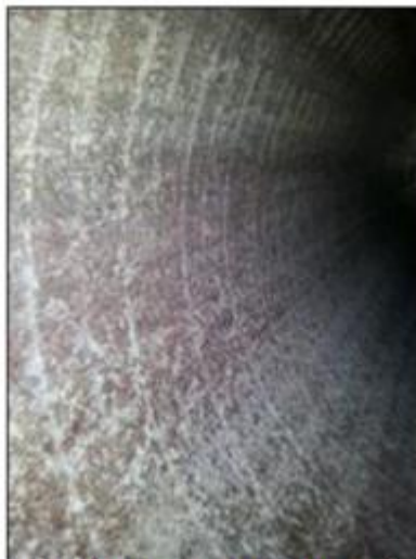
Рисунок 13 – Вид внутренней поверхности нефтепровода после очистки
