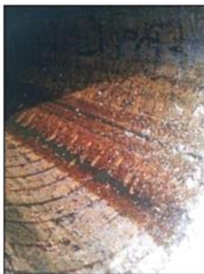
Рисунок 12 – Вид внутренней поверхности нефтепровода перед очисткой
