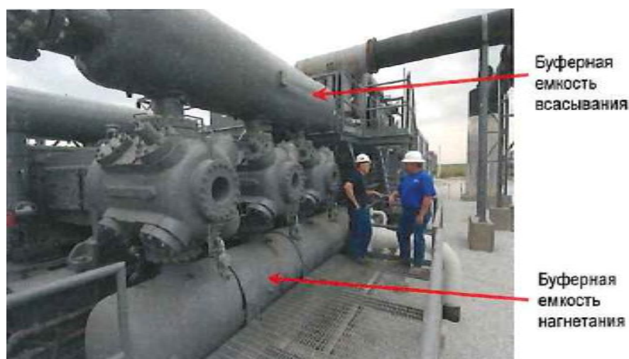
Рисунок 11- Буферная емкость
