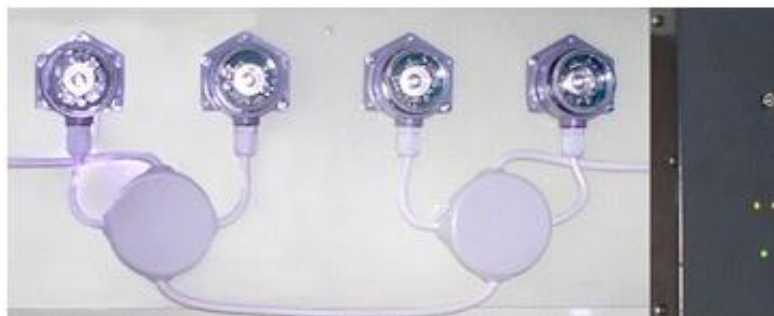
Рисунок 14- Система аварийного освещения «Экотон - 12»
