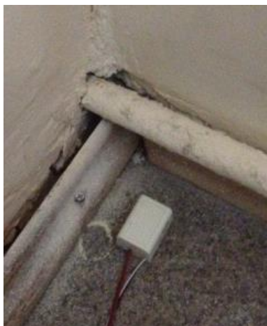
Рисунок 4.38 – Акселерометр на полу читального зала V этажа
