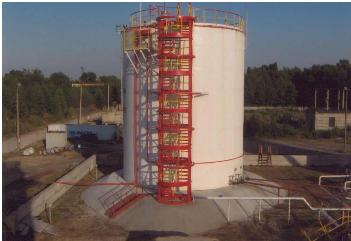
Рисунок 1.4.7 – Шахтная лестница РВС
