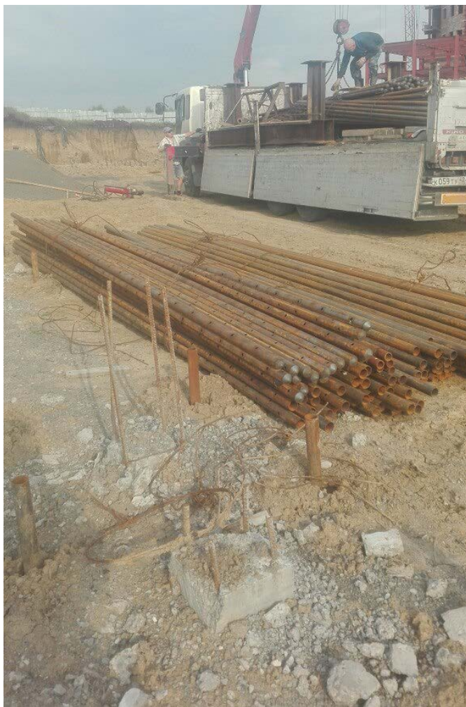
Рисунок 3.16 Подготовительные работы по установки инъекторов, согласно проекту [88]
