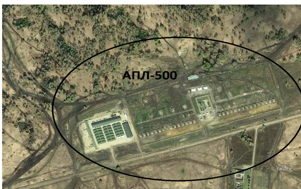
Рисунок 11– Расположение АПЛ-500 на полигоне
