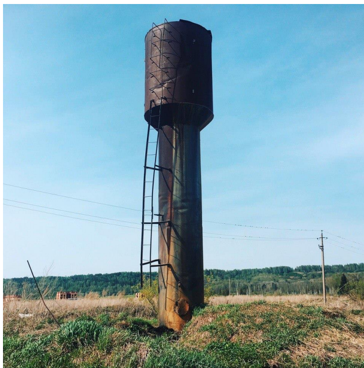
Рисунок 6 –Водонапорная башня на территории села Коларово [15]
